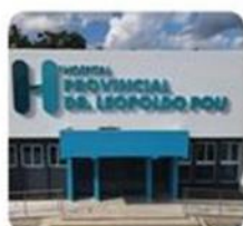
📍 Santa Bárbara de Samaná Hospital Leopoldo Pou • Remozamiento general
