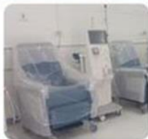
📍 Samaná Construcción de Unidad de Hemodiálisis • En proceso
