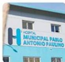
📍 Las Terrenas Hospital Municipal Pablo Antonio Paulino • Remozamiento (Ministerio de Obras Públicas)
